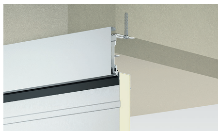
A nyílás elé rögzítve
